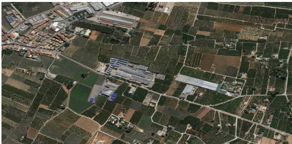
Foto 1 Vista aérea del entorno.
