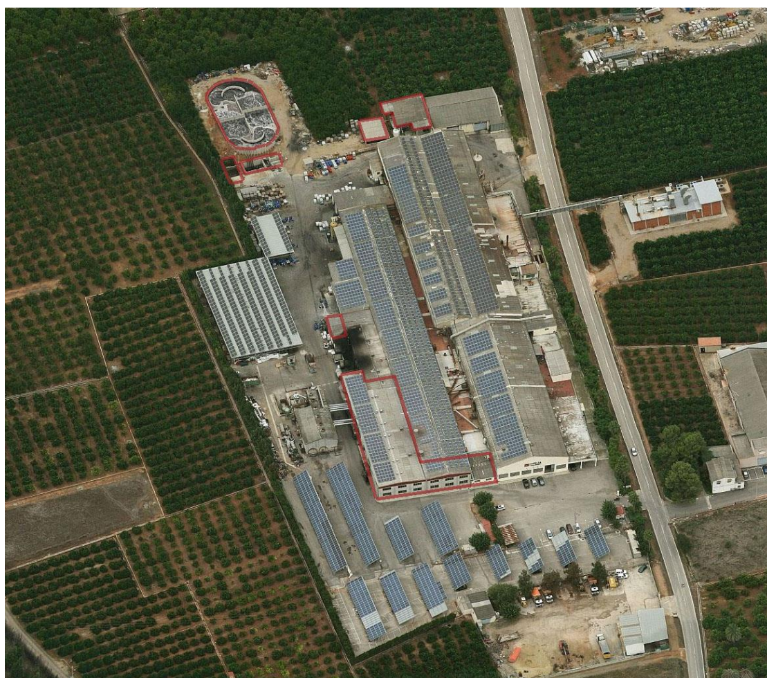
Foto 6 Foto aérea donde se remarcan los edificios a legalizar.
