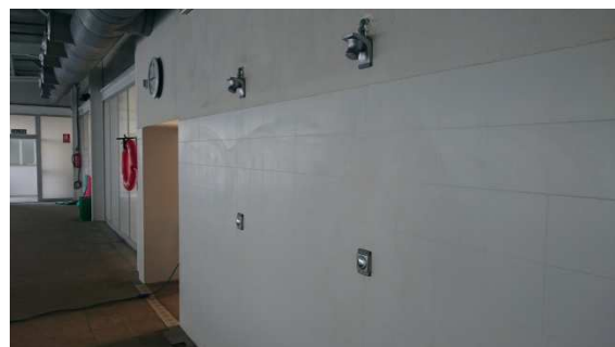
Imagen 53: En esta se pueden observar las dos duchas , la entrada a la piscina a la derecha y al fondo una salida de emergencia.
