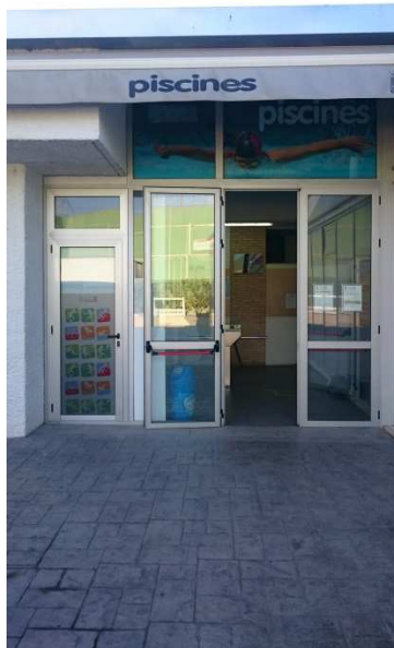
Imagen 4: Entrada principal de la instalación, donde se aprecia a la derecha la entrada de los clientes y a la izquierda la de recepción.
