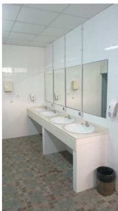
Imagen 28: Pilas situada en frente del lavabo de minusválidos.
