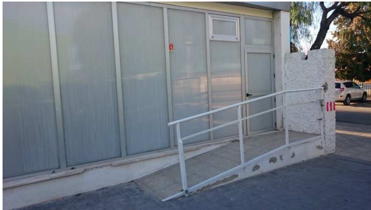
Imagen 1: En esta imagen se puede apreciar la entrada del polideportivo y la salida de emergencia de la piscina cubierta.
