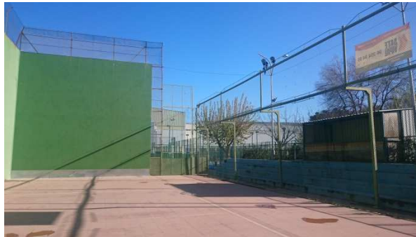
Imagen 71: Vista general del frontón.
