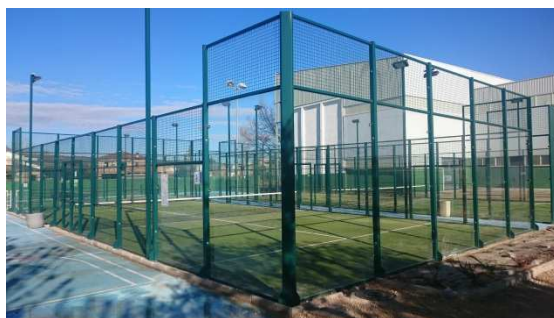
Imagen 82: Vista general desde el exterior
