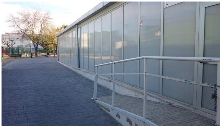
Imagen 2: En esta continuamos viendo la salida de emergencia y toda la pared exterior de la piscina.
