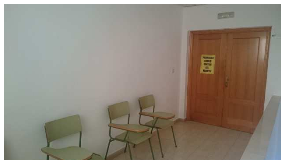
Imagen 114: Entrada a la sala
