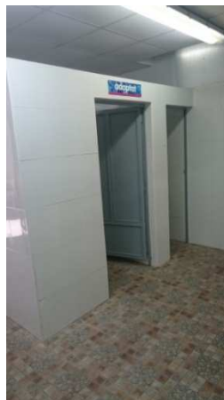
Imagen 20: Lavabos del vestuario situados a la izquierda de la entrada, siendo uno de ellos el de minusválidos.
